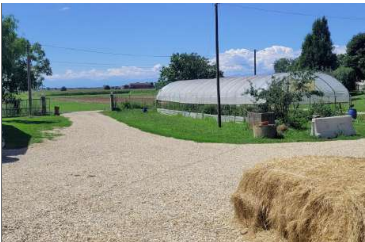
Figura 2 – Piazzale avente pendenza verso Sud in modo da far defluire eventuali acque di esondazione verso Via Pirandello e i terreni di proprietà oltre la stessa.
